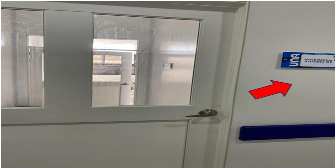
Imagen nro. 39. Habitación ocupada sin la señalización de las medidas de aislamiento
